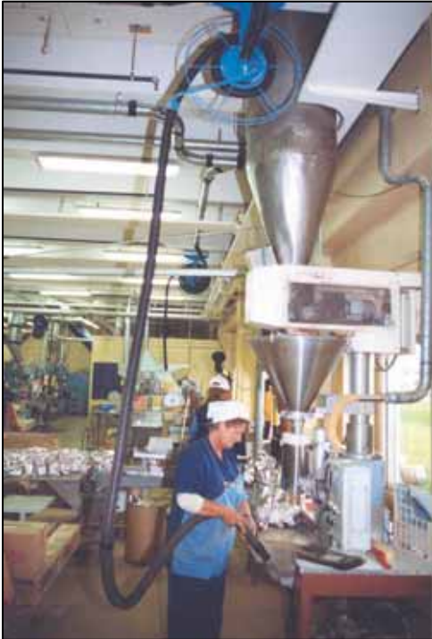
Zentrale Staubsauganlage, Dänemark
