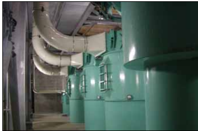
Zuckerfabrik in Deutschland 4 x SimPact® 4T-R Filter
